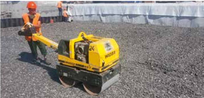
Рис. 8. Пример выполнения работ с использованием виброкатка
