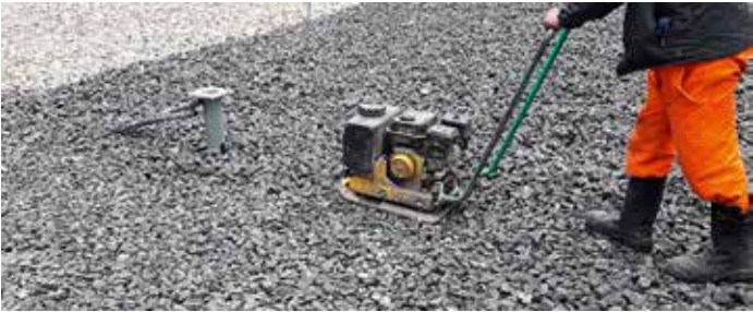
Рис. 7. Пример выполнения работ с использованием виброплиты
