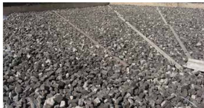
Рис. 2. Построение плоскостей при помощи металлических направляющих
